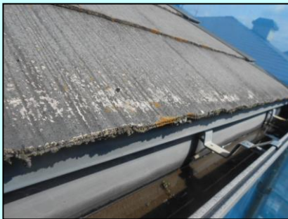
屋根の塗装が剥がれ、コケが生えています
