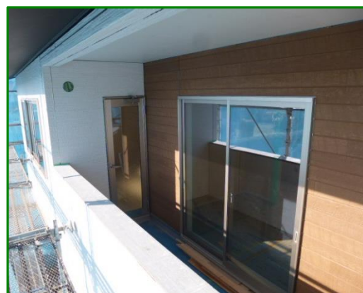
真っ白な外壁にフラウンのベランダ 素敵な外観が現れました。
