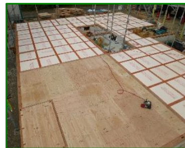
断熱材を敷き詰めていきます。
