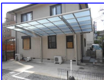
カーポート設置工事
