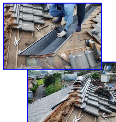
瓦屋根補修工事
