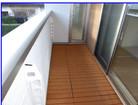
ベランダは人工木樹脂のウッドデッキで雨に濡れても大丈夫。
