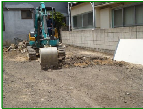
アスファルトを剥がします。
