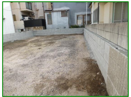
新築工事に先だって、 ブロック塀を新設しました。
