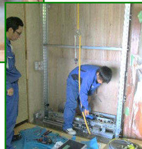
エレベーターを設置します。
