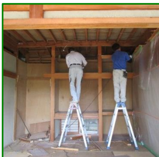
解体していきます。
