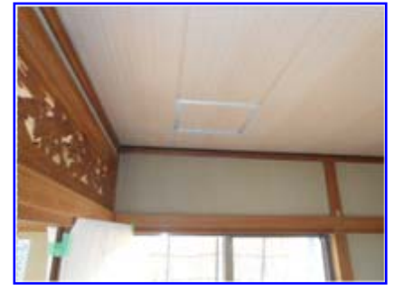
補修後 天井を新しく貼り替えました
